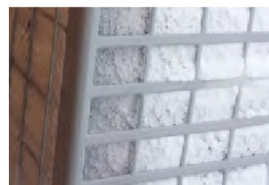
Parownik pokryty lodem
