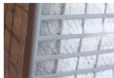
Parownik pokryty lodem
